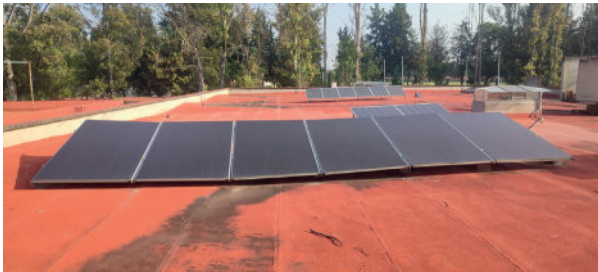
Figura 3. Paneles conectados en serie.
